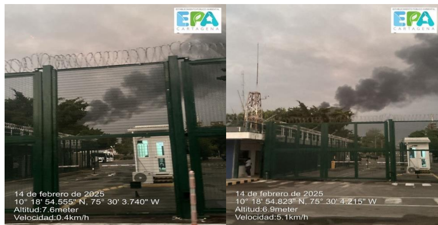
Imagen 1 y 2. Fuente Fija la TEA realizando la Quema de combustible.
